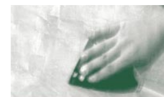
Durch das Abziehen mit der Spachtel wird die Oberfläche spiegelblank.
