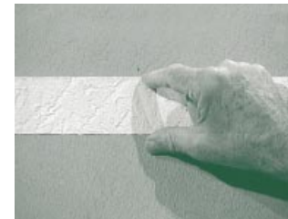
Erhabene Bordüren lassen sich mit Spachtelputz leicht herstellen.
