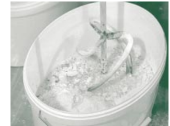
Kalk-, Gips- und Lehmputze mussen mit Wasser angeruhrt werden.
