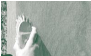
Schraubt man den Stiel der Ovalbürste ab, hat man ein besseres Gefühl für die Bewegung.
