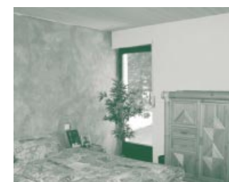
Auch bei optimalen Wandbelägen muss überschüssige Feuchtigkeit durch Lüften beseitigt werden.
